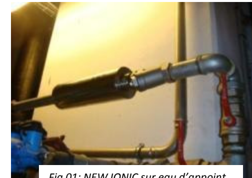
Fig 01: NEW IONIC sur eau d'appoint
